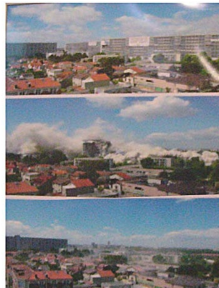
図6 仏の社会住宅の爆破解体の状況 ANRUの取組
