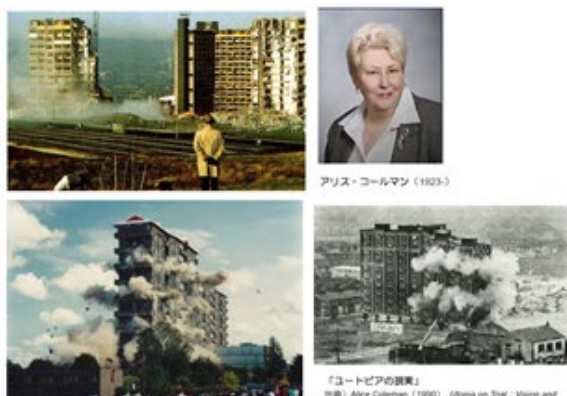
図5 英の公営住宅の爆破解体とAコールマン
